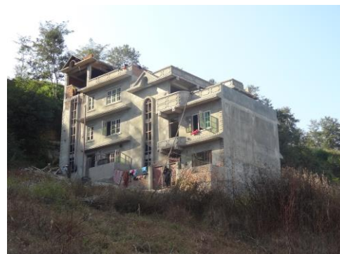
購入した土地で建設中の建物(左側)
