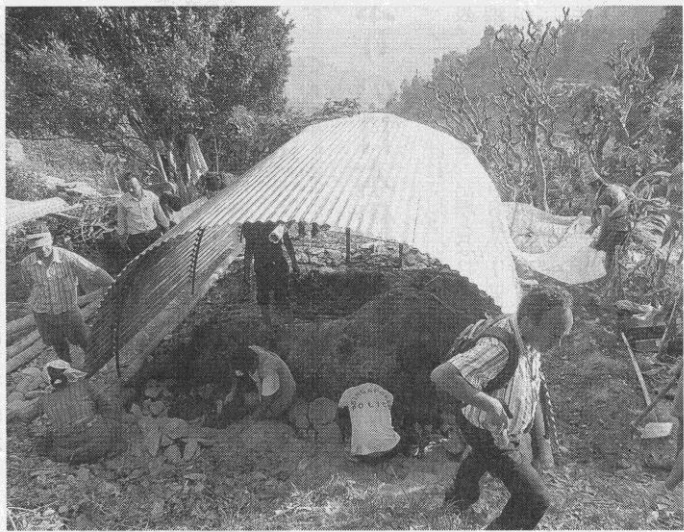
被書がより深刻なネパールの農村部。首都カトマンズから40キロ離れた被災地をかまほ型仮設住宅を建てる東京都市大のリジャル准教授(右手前)ら(同大の岡田啓准教授提供)
