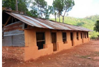
廃材で建てた 4 教室の仮校舎
