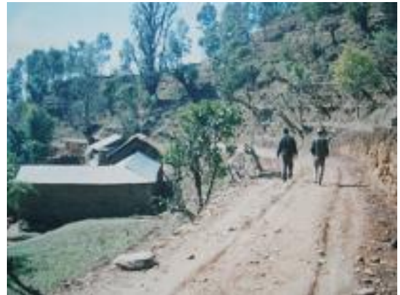
サッレ村に建設された道路
